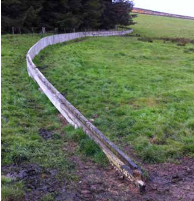
▲ Träkonstruktion på en sluttning i betesmark för att fördröja vatten som flödar ovan markytan. Detta bidrar till minskade flöden i nedströms liggande vattendrag. Foto: Anita Bergstedt.
