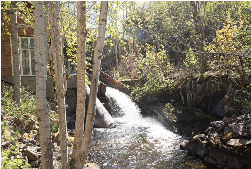
Figur 10. Nedströms Stigen västra kraftverk
