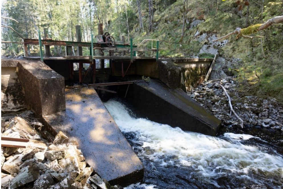
Figur 12. Regleringsdammen vid Nyckelvattnets utlopp.
