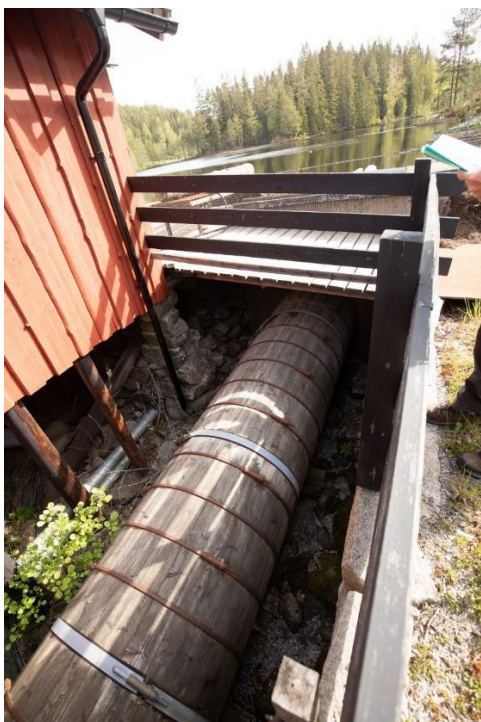
Figur 7. Intagstuben till kraftverket
