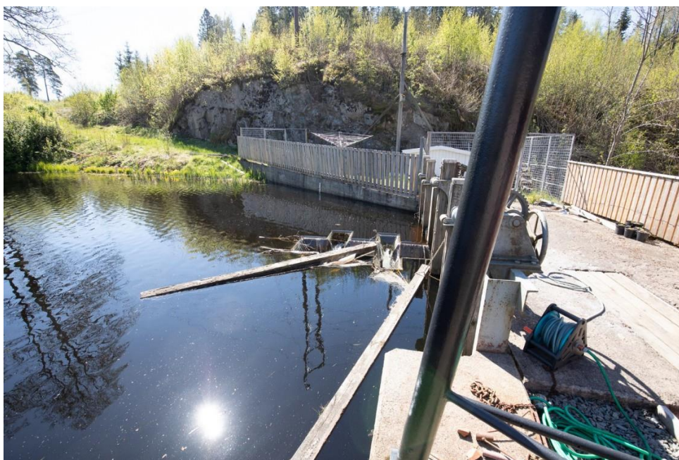
Figur 9. Regleringsdammen vid Stigens nedre kraftverk.
