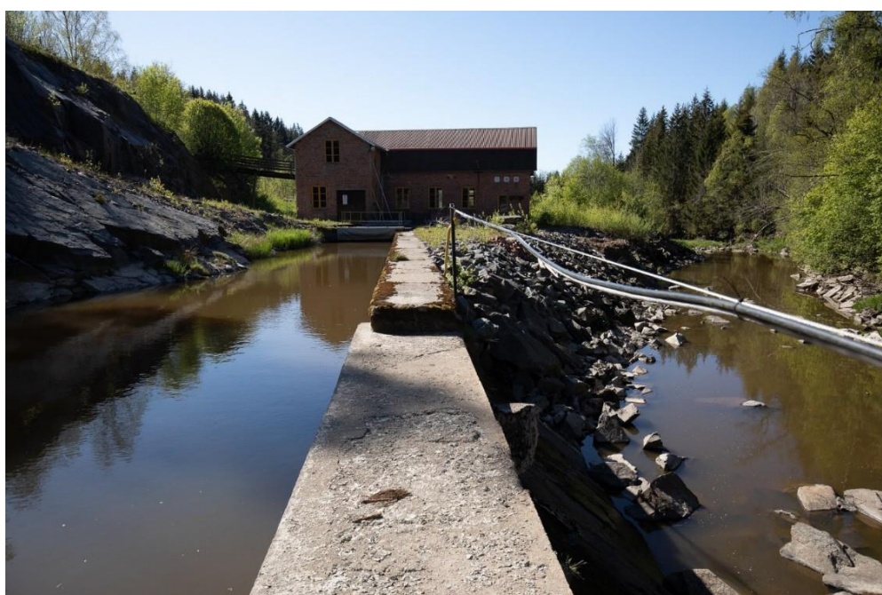
Figur 5. Intagskanalen till Näsböle kraftstation
