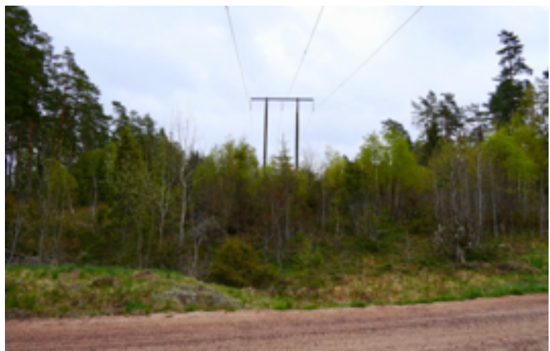
En tidigare, för viltet, skött kraftledningsgata där växtligheten blivit för hög.
