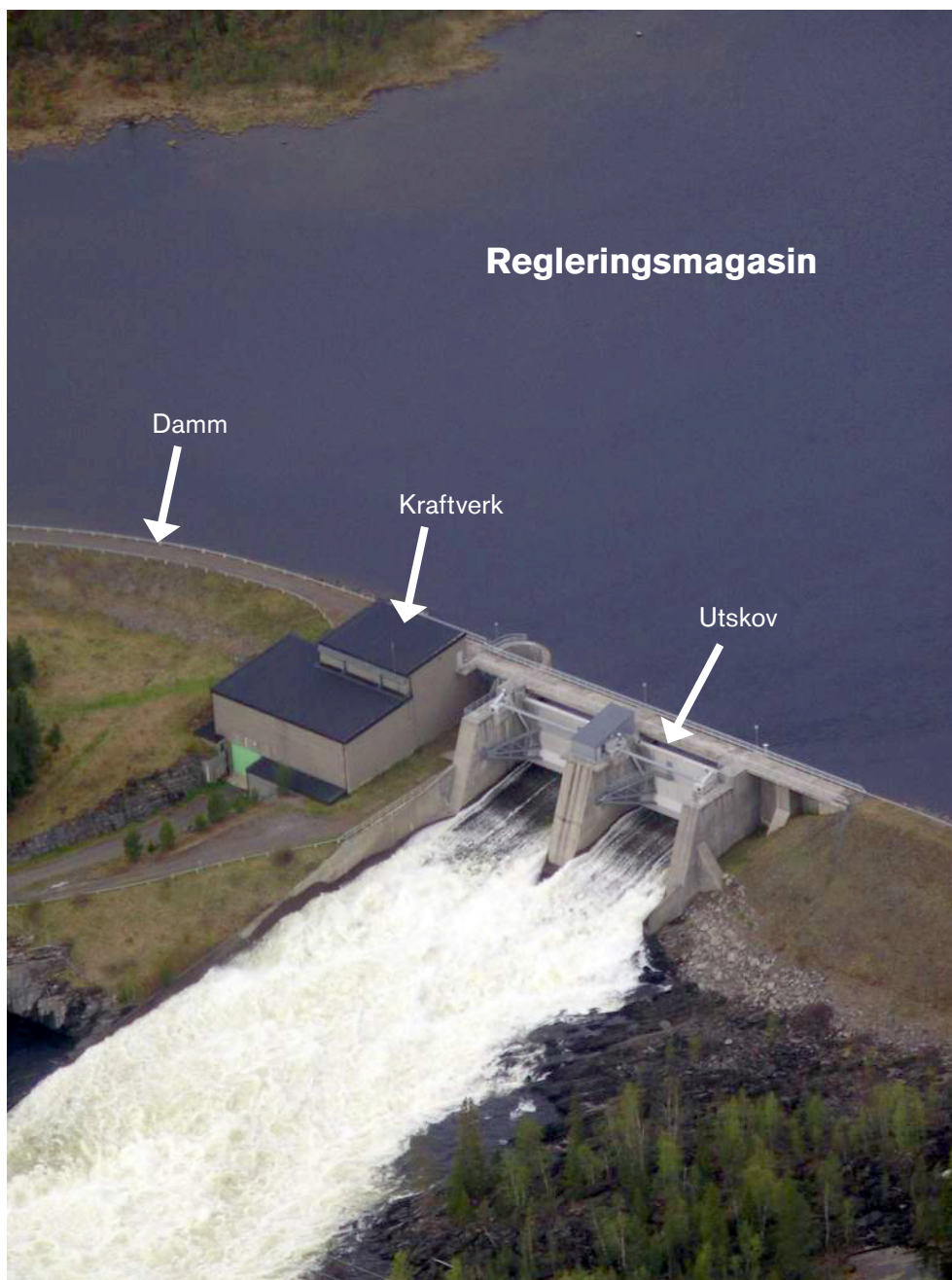
Förklaring av vattenkraftsbegrepp. Från Näsforsen, Härkan. Foto: Länsstyrelsen Jämtlands län, 2003.
