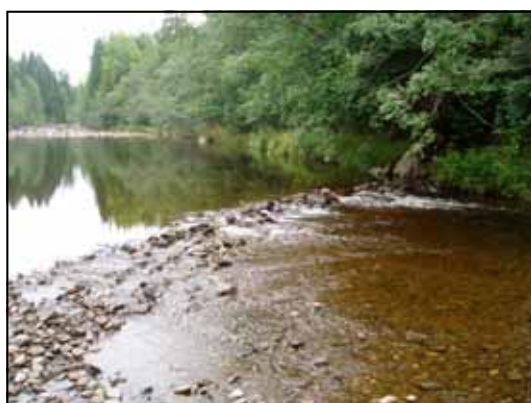
Figur 4. Fördämning som utgör vandringshinder (tabell 3, hinder 1).
