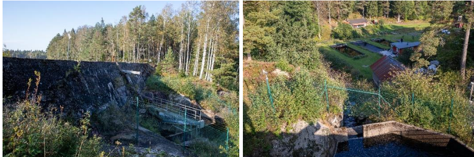
Figur 8. Bild t.v. Fördämningen en vid Kvarndammen med vattenreservoaren nederst i bild. Bild t.h. Utskovsluckan i vattenreservoaren och Laxforsens kraftverk strax nedanför fördämningskonstruktionen (byggnaden närmast i bild).
