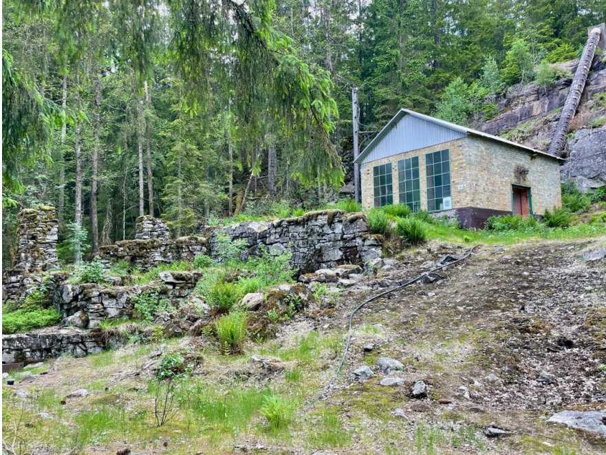
Figur 2. Kraftverksstationen bland ruiner från äldre verksamheter.
