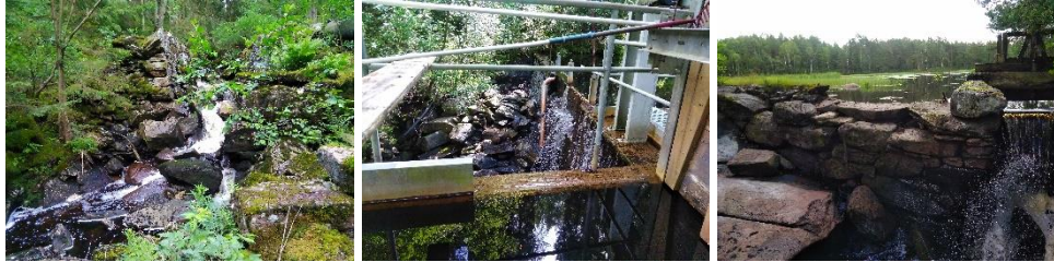
Figur 3. Bild t.v. Vandringshinder vid Flygsnäs kraftverk. Bild mitt. Verksdammen. Bild t.h. Flygsnäs dammanläggning med regleringsluckan till höger i bild.
