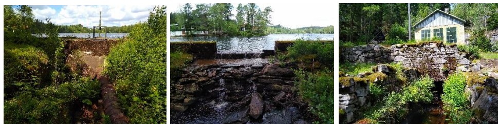
Figur 1. Bild t.v. Vattenintag till kraftverket med tuben nederst i bild. Bild mitt. Utskovet som reglerar vattennivån i Hällsjön. Bild t.h. Bugärde kraftverk med utloppskanalen närmast i bild.
