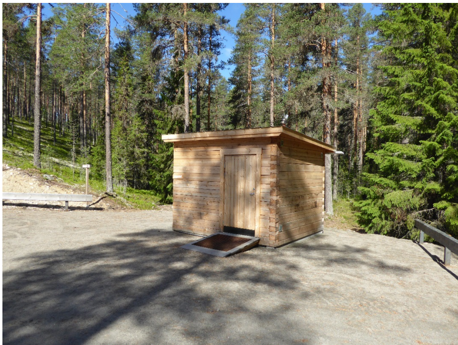
Torrtoalett vid parkering.
