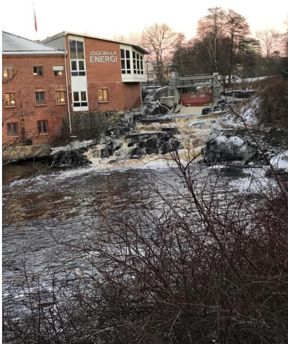
Figur 1. Strömbergets kraftverk och vattenfallet. Foto taget år 2020, Länsstyrelsen
