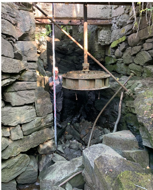
Figur 13. Nedre delen av det branta fallet inuti kvarnruinen, med turbinsump.
