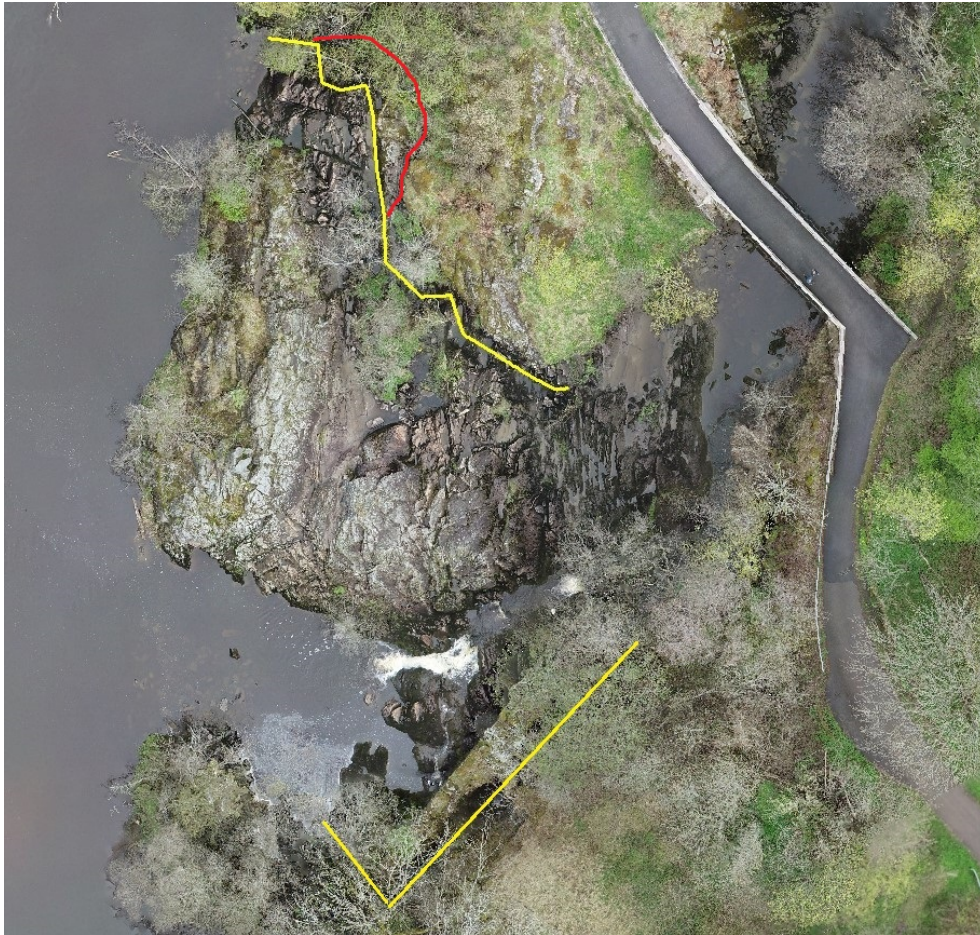
Figur 9. Drönbild över Fossums kvarn med bedömd bästa vandringsväg för lax och öring (gul överst) och alternativ väg (gul nederst). Röd väg är en alternativ, flackare väg.
