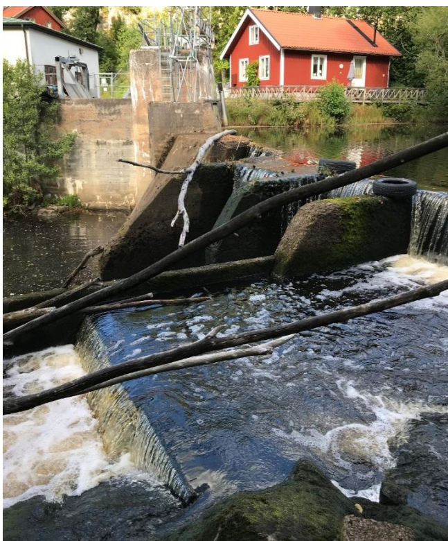
Figur 4. Dammen vid K2 St Anna Äng kraftverk
