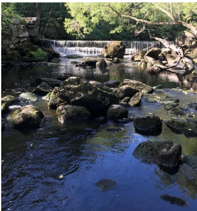
Figur 5. Äsperöds kvarndamm från nedströmssidan innan utrivningen
