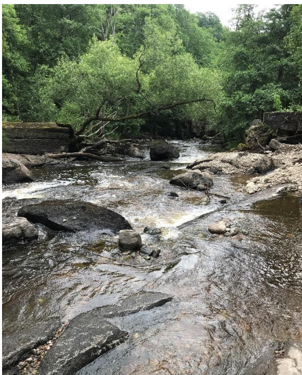
Figur 6. Äsperöds kvarndamm från uppströmsidan efter utrivningen, 13 juli 2021.
