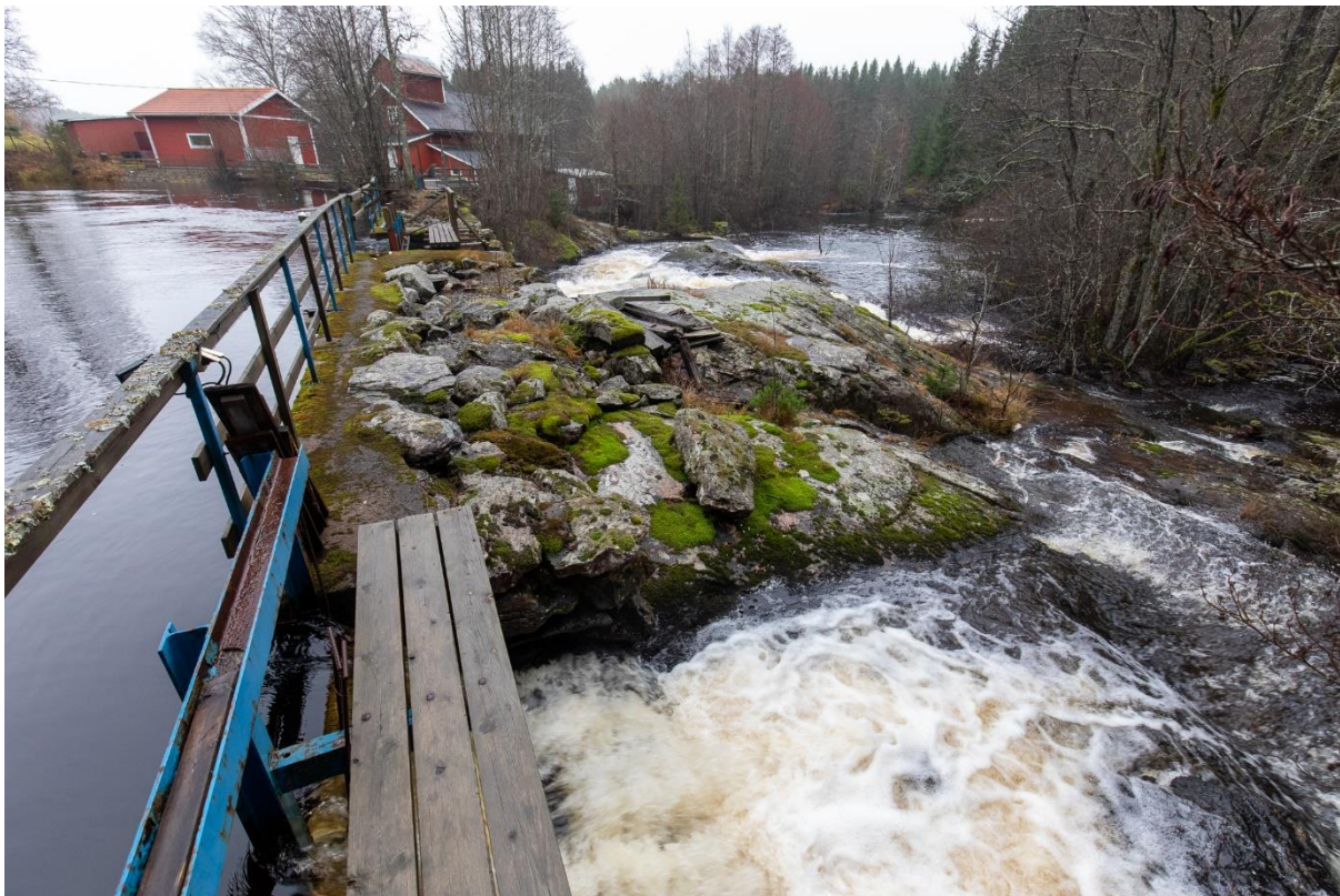
Fig 14 Regleringsdammen vid Loviseholms kraftverk
