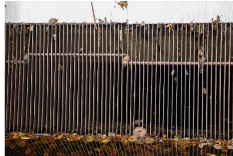
Figur 21. Bild t.v. Översiktsbild. Bild t.h. Intagsgaller med varierande spaltvidd.
