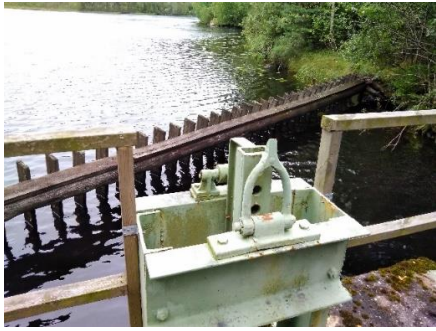
Figur 26. Bild t.v Grovgaller i trä och utskovslucka. Bild t.h. Intagsgaller innan tub
