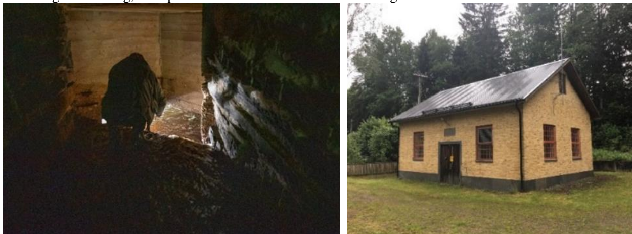
Figur 7. Bild t.v. Vertikal klack inne i kulverten för Tolaredsbäcken under Gökalids kraftverk, där den ansluter till utloppskanalen från kraftverket. Bild t.h. Gökalids kraftverk.
