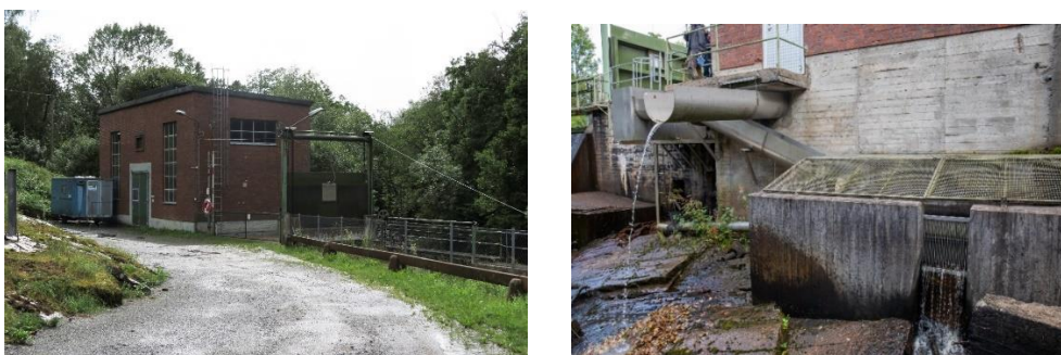
Figur 11. Bild t.v. Bosgårdens kraftverk. Bild t.v. Rensrännan överst och avledningsrännan från gallret ner till fiskfälla
