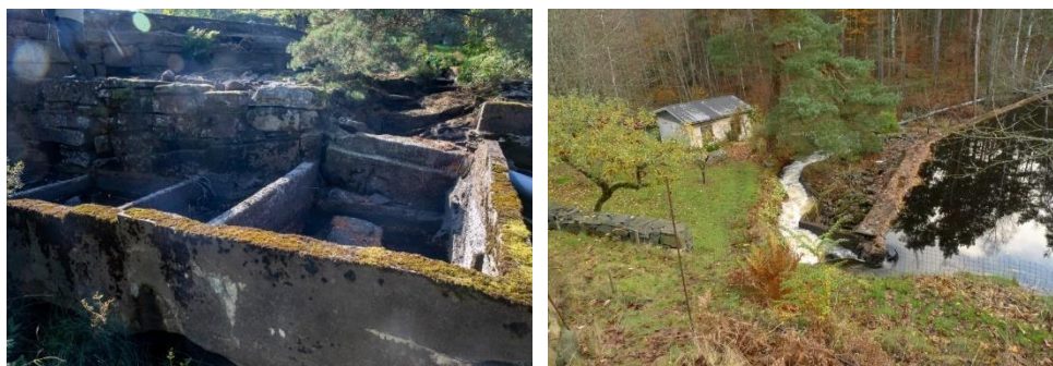
Figur 4. Bild t.v bassängtrappan vid Ekåfallets damm. Bild t.h översiktspild. Foto Länsstyrelsen
