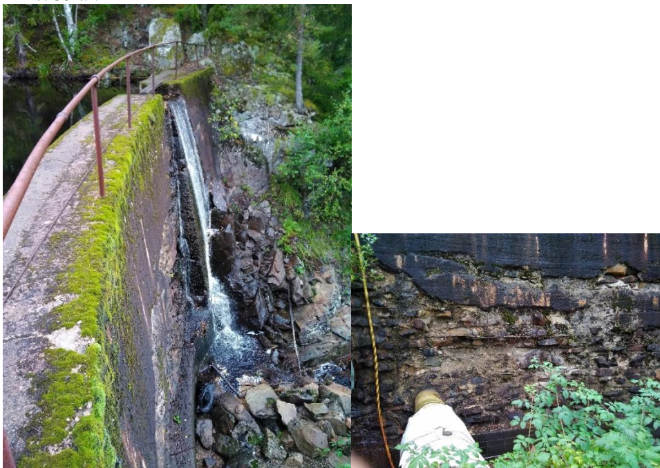
Figur 23. Dammen vid Sandhults kraftstation med tub i botten
