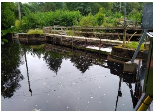
Figur 22. Dammen vid Hulta kraftverk, till vänster syns utskovet till omlöpet och till höger benen till rensmaskinen vid fingallret framför inloppet till intagskanalen.
