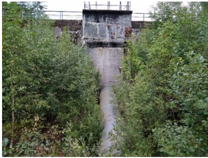
Figur 28. Bild t.v Sångåsens kraftverksdamm med tub. Bild t.h. Sångåsens kraftverk
